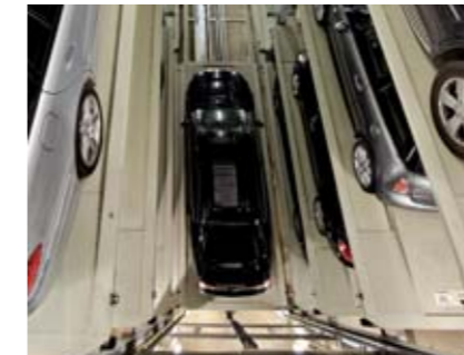
10 Sobald der Vertikalförderer die vorgesehene Parkebene erreicht hat, wird er verriegelt.
