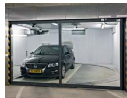
08 bis die Position über dem Vertikallift erreicht ist. Der Vertikallift übernimmt die Palette until the position above the vertical lift has been reached. The vertical lift takes over the pallet
