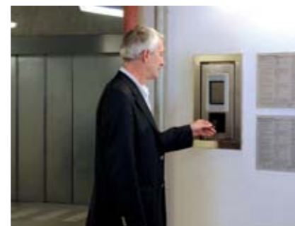
05 An der Wand außen vor dem Übergabebereich bestätigt der Fahrer seinen Einparkvorgang berührungslos mit seinem Transponder. Nachdem Laserscanner an der Decke die richtige Positionierung des Pkw geprüft haben, wird
