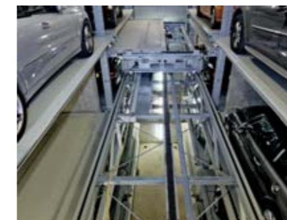
13 Danach wird eine Leerpalette aus dem Zwischenlagerspeicher auf das Shuttle geholt und in den Übergabebereich
