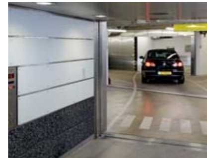
03 Sobald der Autoaufzug die untere Ebene -2 erreicht hat, öffnet sich das Tor der Aufzugskabine, gleichzeitig öffnet sich das Schiebetor zum Übergabebereich, wo eine Leerpalette für den Einparkvorgang bereitsteht.
