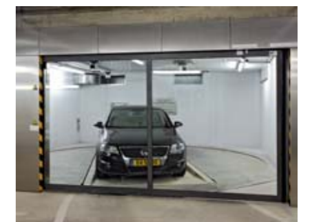
18 Im Übergabebereich wird das Fahrzeug in Ausfahrposition gedreht.
