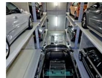
17 Das Fahrzeug wird zum Übergabebereich gebracht, während die Fahrerin noch im Personenaufzug bis zur Ebene -2 fährt. So wird die Wartezeit reduziert.
