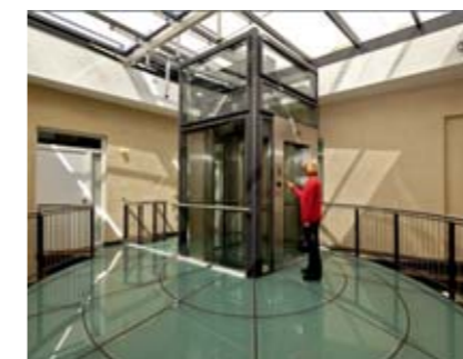
16 Schon im obersten Stockwerk des Gebäudes kann die Nutzerin mit dem Transponder ihr Fahrzeug am mehrsprachigen Personenaufzugsterminal anfordern.
