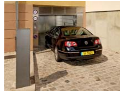
02 Dann fährt der Fahrer seinen Pkw in die großzügig gestaltete Autoaufzugskabine, schaltet den Motor aus, das Tor schließt und der Autoaufzug fährt automatisch ins Untergeschoss.
