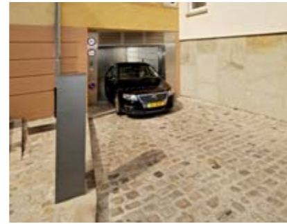
21 Das Aufzugstor öffnet sich automatisch zum Ausfahren.
