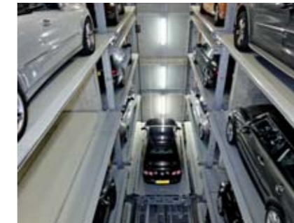
11 Das Shuttle auf dem Vertikalförderer verfährt, um die weitere Parkreihe zu erreichen.
